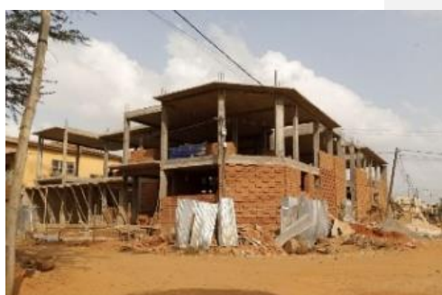
Résidence en plein chantier à st Joseph
