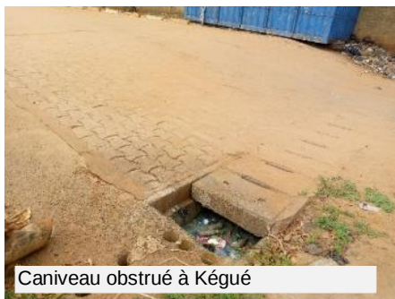
Planche 8: caniveau obstrué et caniveau en construction
