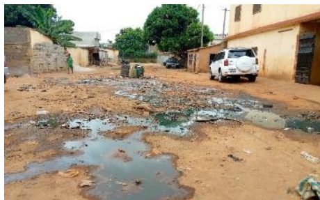
Rejet des eaux usées et déchets à lieu ?Kégué
