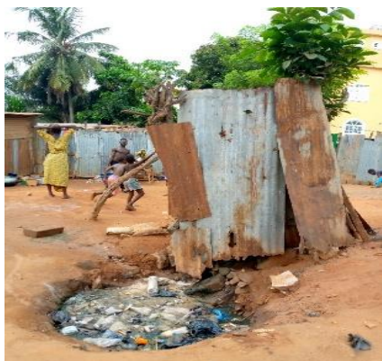
Toilette et rejet des eaux usées des douches rue
