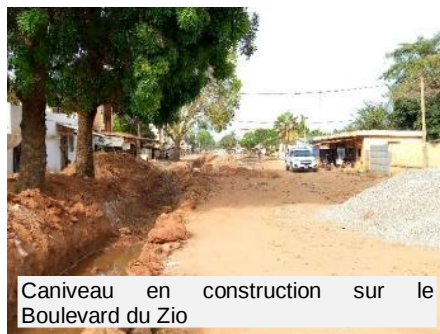
Planche 8: caniveau obstrué et caniveau en construction
