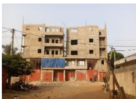
Maison entrepôt en construction à Hédzranawoé
