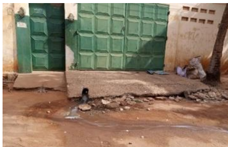
Canalisation de rejet des eaux vannes dans la rue
